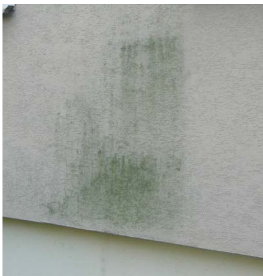
Obr. 1 Příklad lokálního výskytu řas na ETICS
