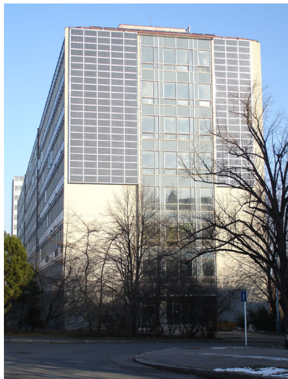
Obr.5 Fotovoltaická stěna na jihozápadní fasádě budovy B
