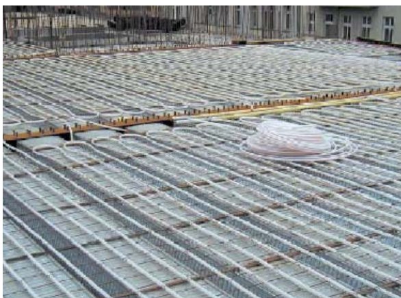
Obr. 4) Aktivace betonového jádra stropu
