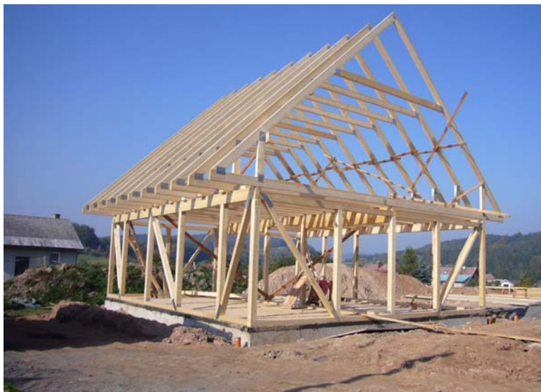
Obr.6 Výstavba dřevěného skeletu pro pasivní dům v Koberovech (autor řešení P.Morávek)
