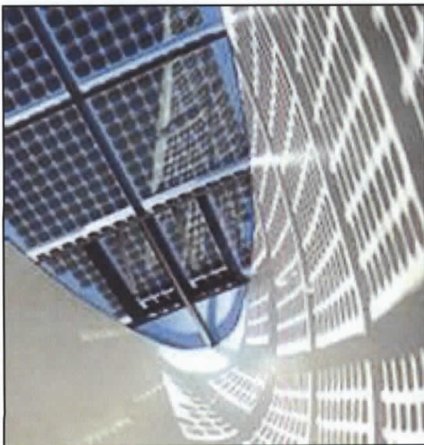
Obr. 1 CSi (kr. křemík) - [ http://www.cipcsp.com/systemes ]
