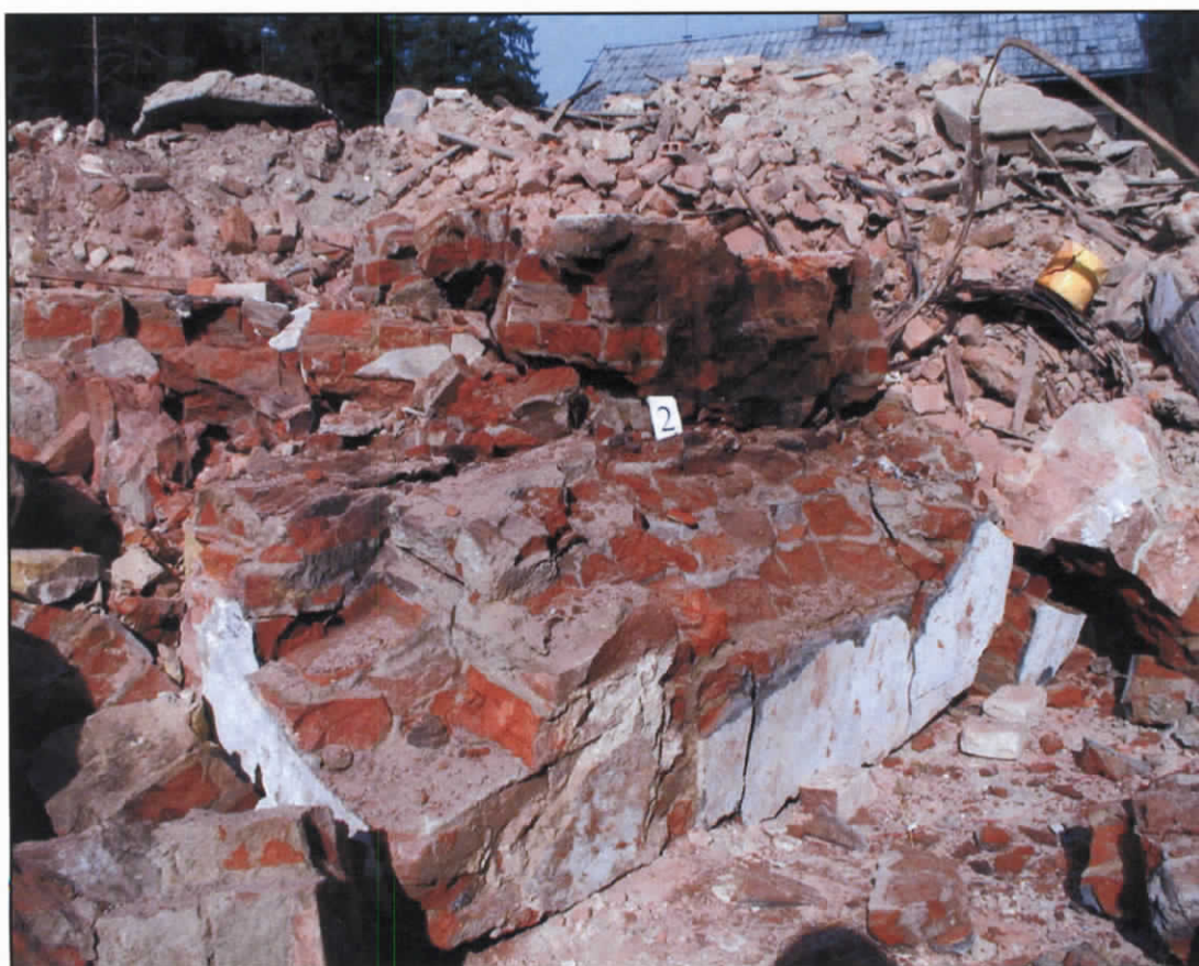
Obr. 2 Blok cihelného zdiva rozpojený náloží pastovité trhaviny
