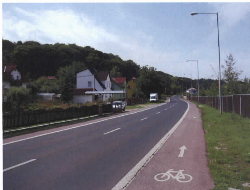
Obr. 2 Komunikace II/261 v obci Olšinky.
