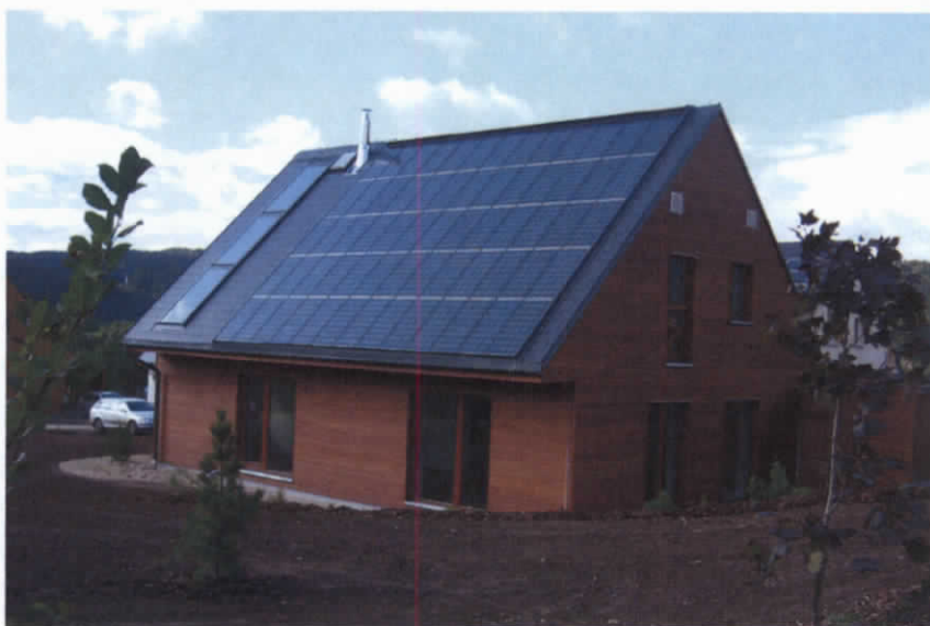
Obr. 3 Experimentální objekt v Koberovech. Velmi úsporné stavební a technologické řešení při garantování kvality vnitřního prostředí je doplněno o finančně náročnou fotovoltaickou instalaci (8,5 kW p špičkového výkonu s předpokládanou roční produkcí 7,5 MWh). Tím se dosahuje se úrovně energeticky nulového domu, pokud do roční bilance energetických toků na vstupu do budovy zahrneme i fotovoltaickou produkci předávanou do veřejné sítě. Skutečné energetické vlastnosti tohoto projektu podpořeného Českou energetickou agenturou budou dlouhodobě monitorovány.
