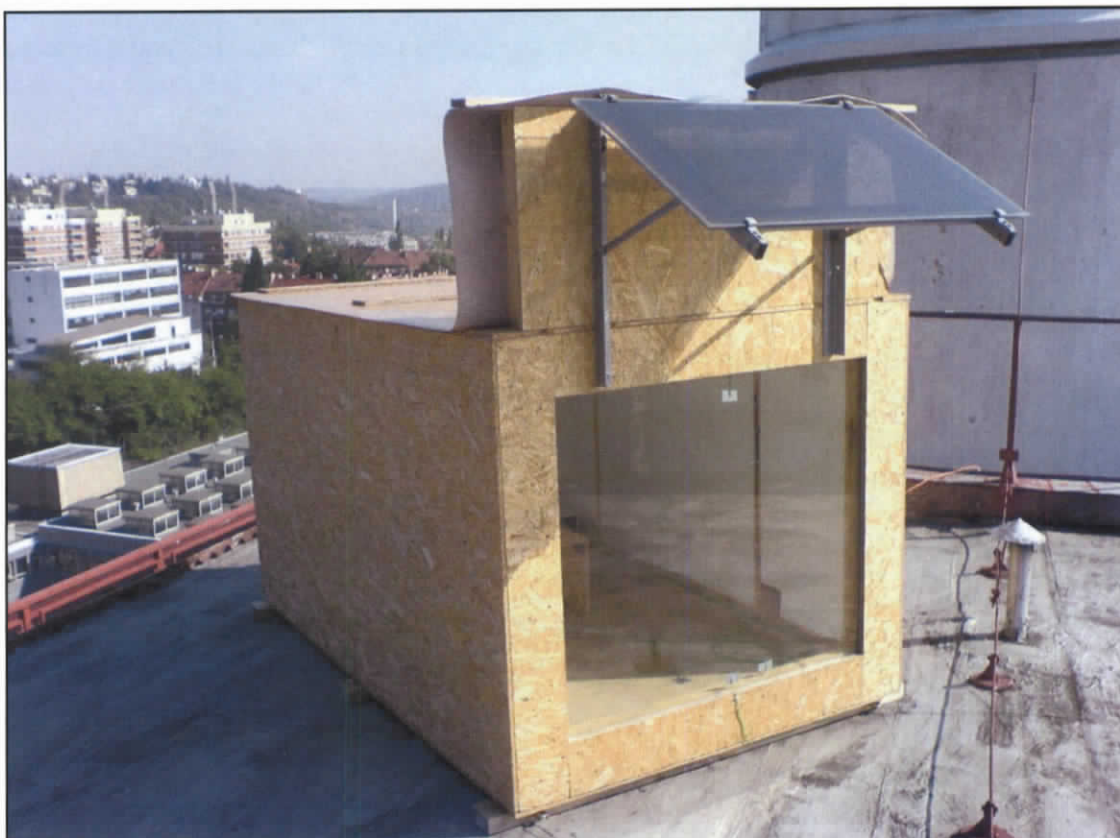
Obr. 3 Pokusná instalace na střeše fakulty stavební ČVUT
