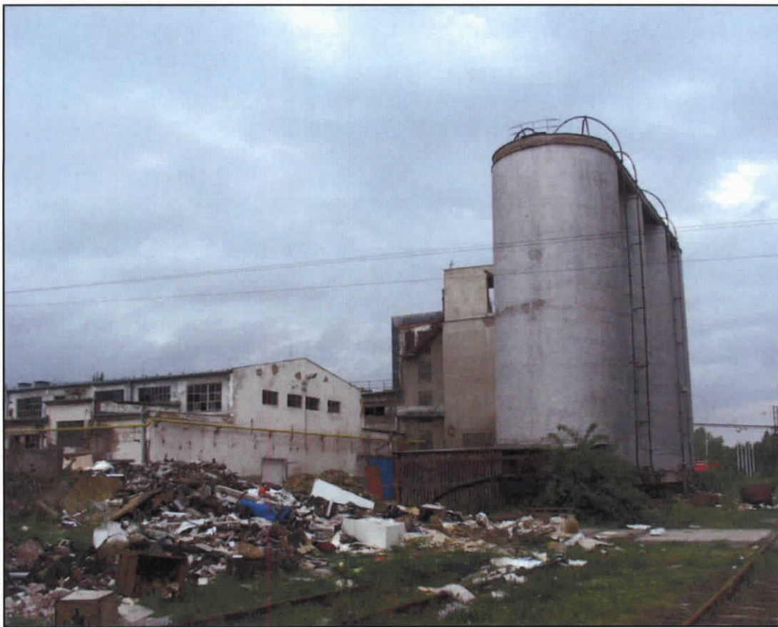
Obr. 1 Pohled na část typické deprimující zóny s objekty určenými k demolici
