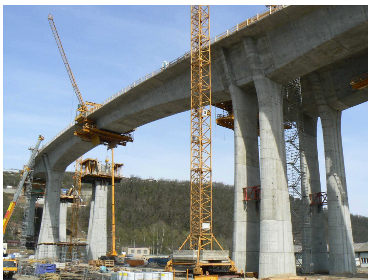
Obr. 1 Letmo betonovaná mostní konstrukce stavby SOKP 514
