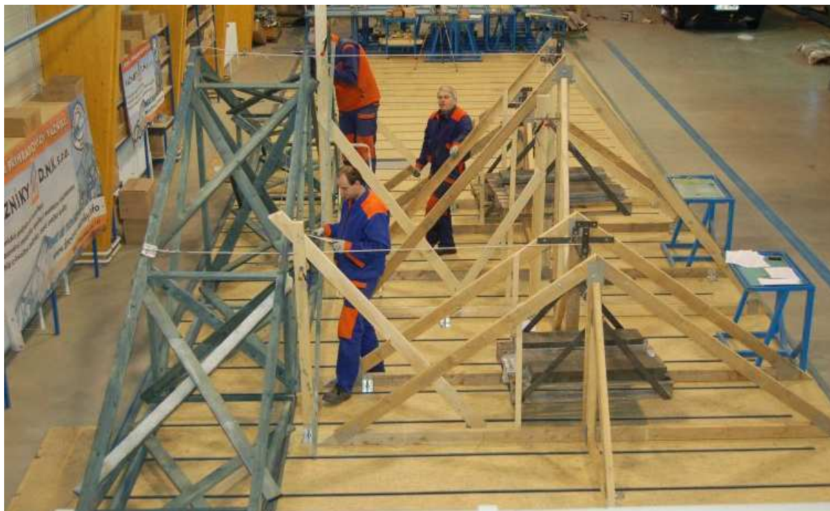
Obr. 3 - Odečet vodorovné deformace ZP3
