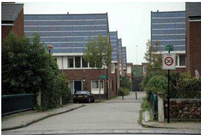
Obr.8: Solární panely umístěné na střechách domů
