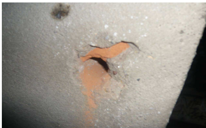
Obr. 3 „Ztužení“ koncových částí mostu
