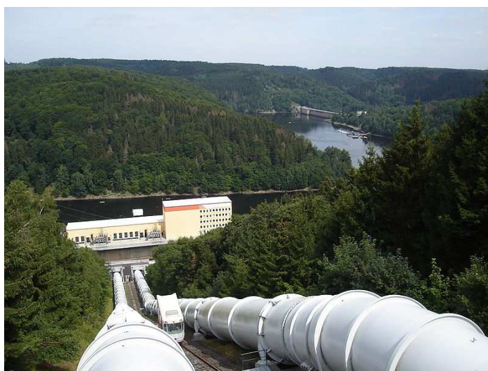
Obr.5: Přecherčpávací elektrárna Wendefurth
