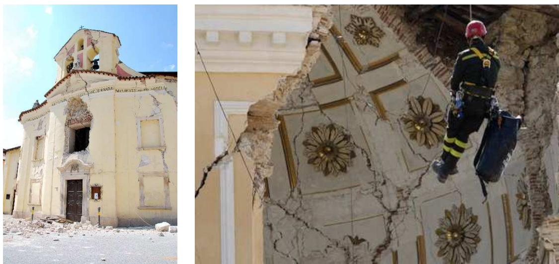
Obr. 3 Historické budovy po zemětřesení, kostel Santa Maria, Paganica
