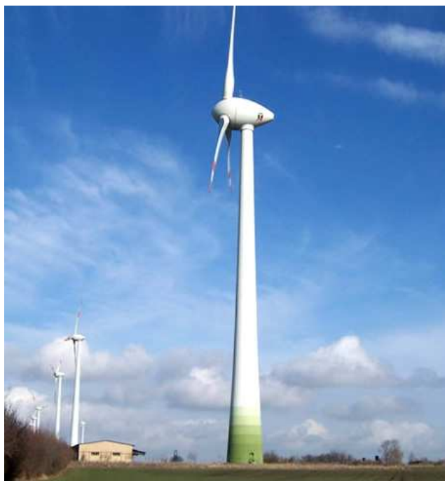
Obr.3: ...a nejvýkonnější a největší elektrárna Enercon E-112 o výkonu 6 MW
