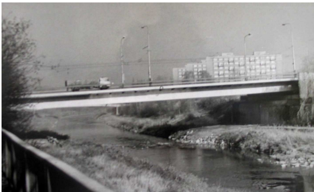
Obr.2) Pohled na most
