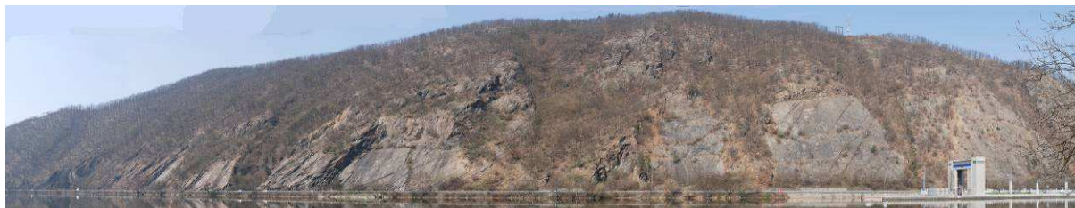
Obr. 2: Pohled na nejrizikovější část – úsek Vrané nad Vltavou
