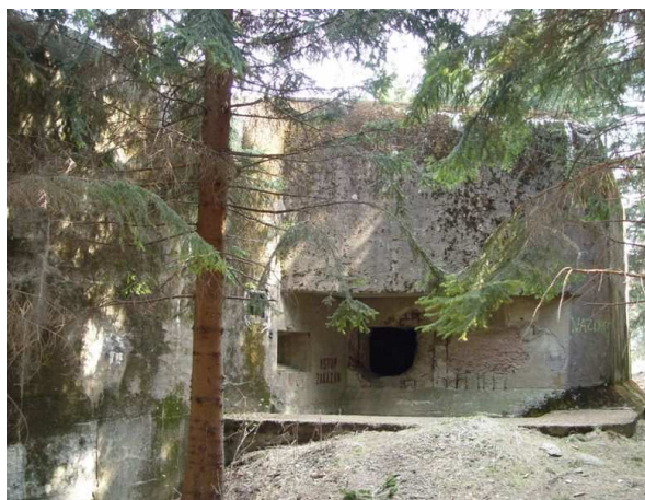
Obr. 2 Současný stav pěchotního srubu N-Sk-S-49 „Pod lesem“
