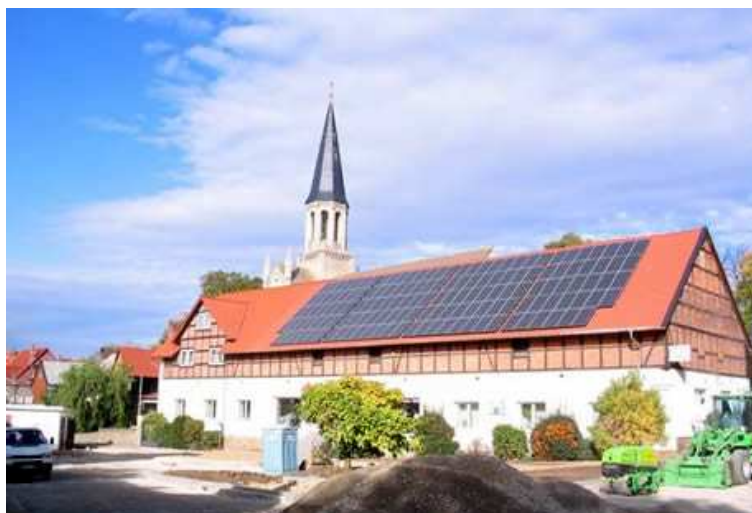
Obr.4: Fotovoltaické články na střeše obecního domu s věží kostela v pozadí
