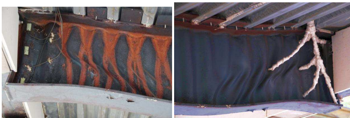
Obr. 13 Smykem deformovaná vlnitá stojina nosníku s tenzometry a termočlánky
