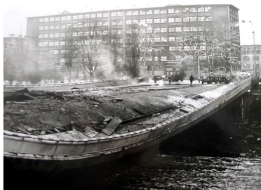
Obr.5) Pohled na most po výbuchu a budovu v těsné blízkosti
